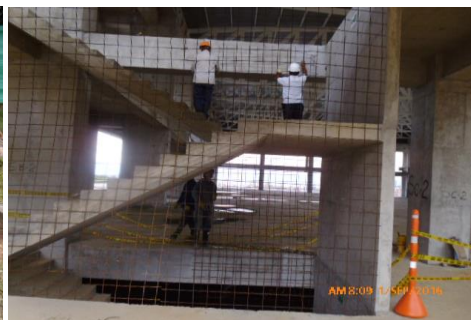
instalación malla electrosoldada protección escaleras
